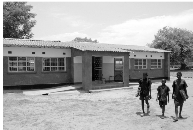
建設中の校舎(上)。新しい教室を使う生徒たち
